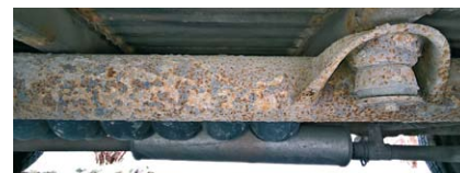
Rama rurowa z widocznym punktem elastycznego mocowania nadwozia
